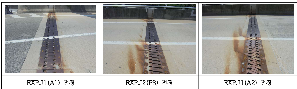
【사진 34.3.17】 신축이음장치 전경
