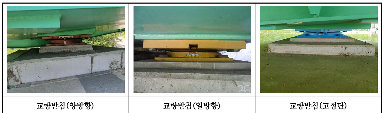
【사진 34.3.13】 교량받침 전경
