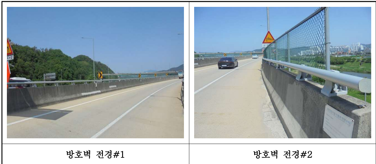
【사진 34.3.24】 방호벽 및 중분대 전경
