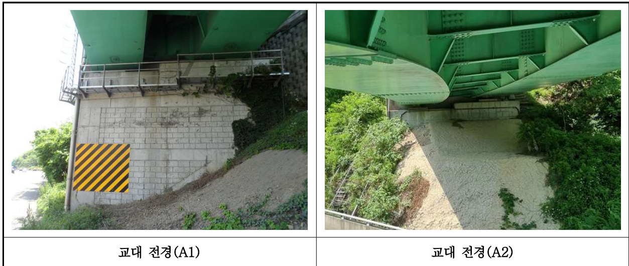
【사진 34.3.8】 교대 전경
