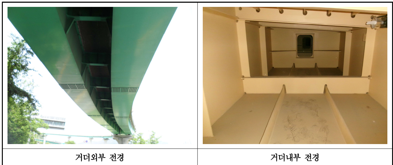
【사진 34.3.4】 거더 전경
